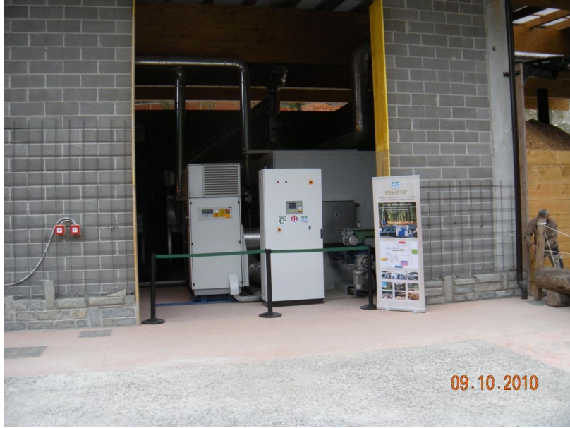
Figura 6 – Impianto microturbina ad aria calda 75 kW Powertep –
