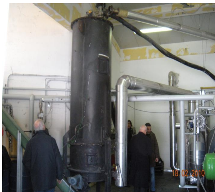
Figura 5 – Gassificatore Updraft – Castel d’Aiano (BO)
