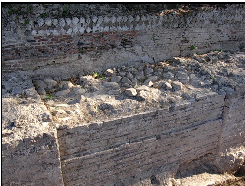
Figura 3 – Muro di cinta della villa dopo lo scavo.
