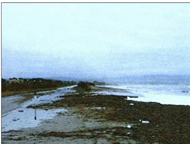
Fig. 1 – Fenomeni di esondazione sul piano stradale prospiciente il tratto di litorale di Maria Pia (1999). Flood phenomena on the street plan, along the Maria Pia coastline (1999)
