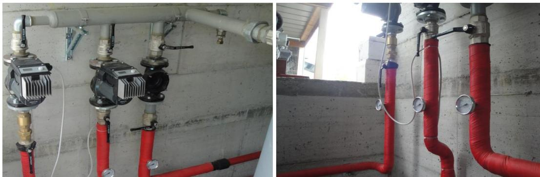
**Fig. 27** Strumenti installati per i rilievi nell'impianto termico dell'azienda Riccianico
