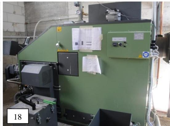
**Figg. 17 e 18** Rispettivamente: impianto termico e caldaia da 150 kW
