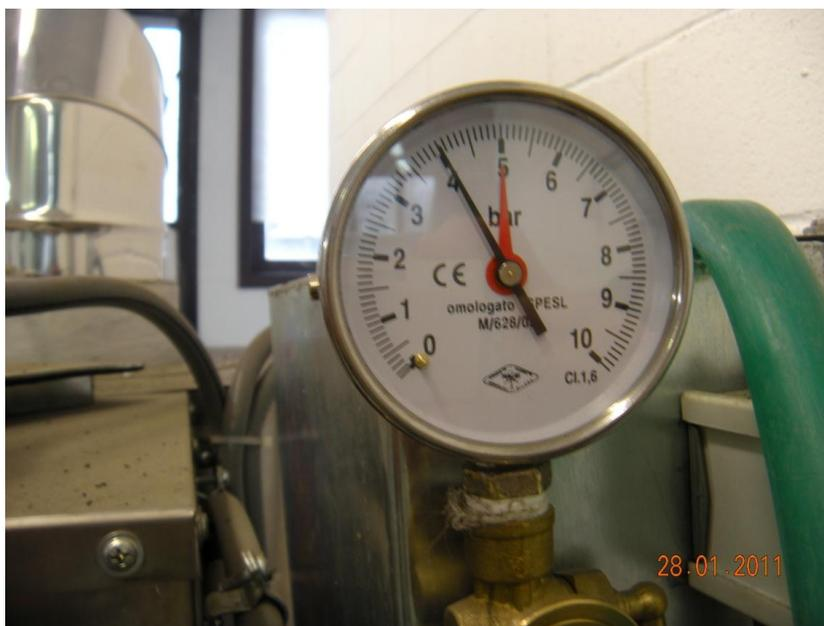
**Figura 3.4 – Manometro pressione del vapore caldaia Toscoaragonese.**
