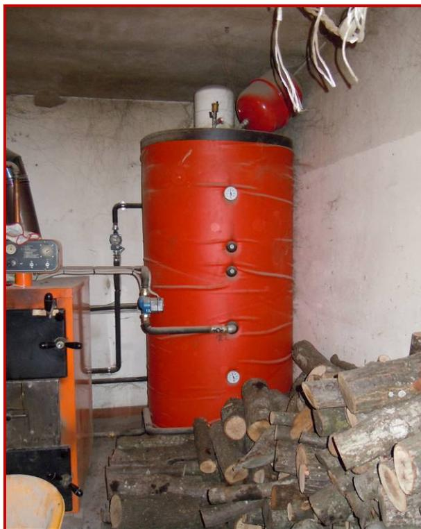
**Figura 32 – Serbatoio di accumulo di ACS**
