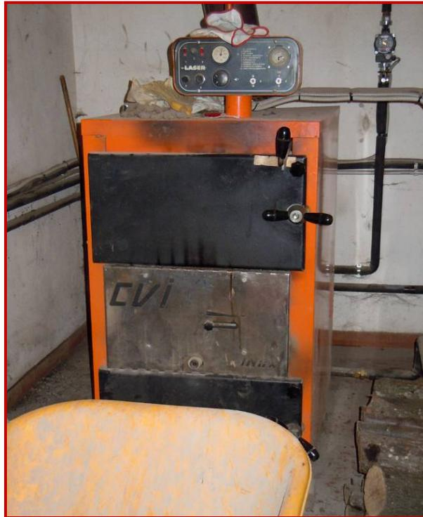
**Figura 31 – Generatore termico a biomassa (ciocchi di legna)**
