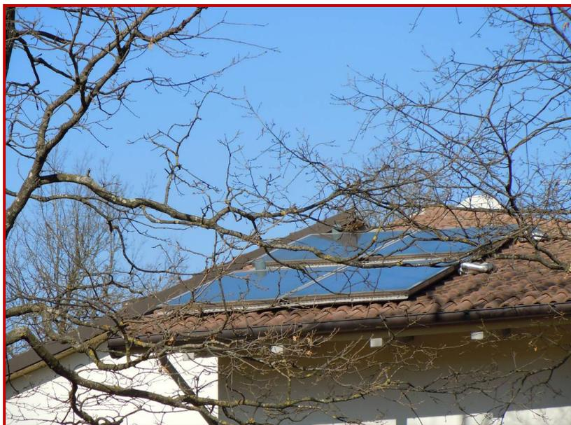
**Figura 36 – Pannelli solari termici posti sulla falda sud di copertura**
