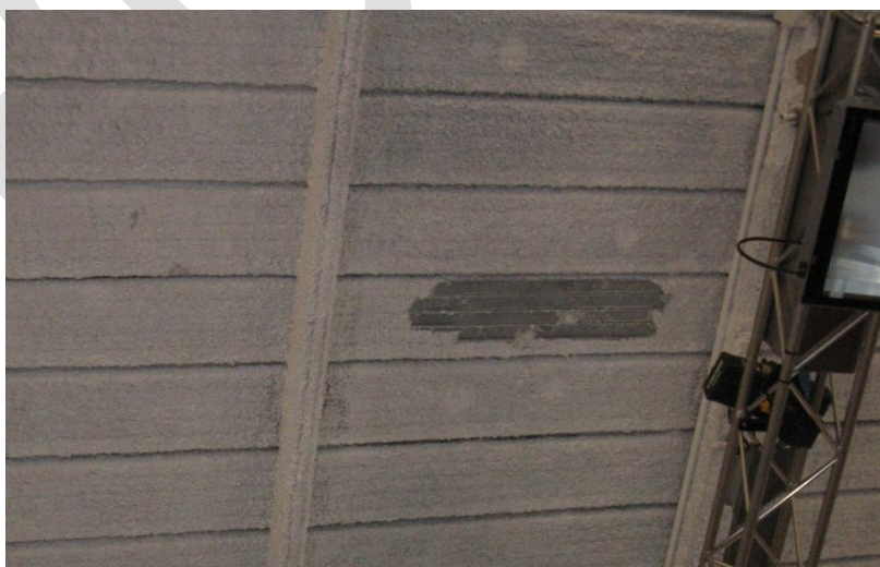
Vista dell'intradosso della copertura
