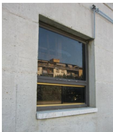
Particolare degli infissi
