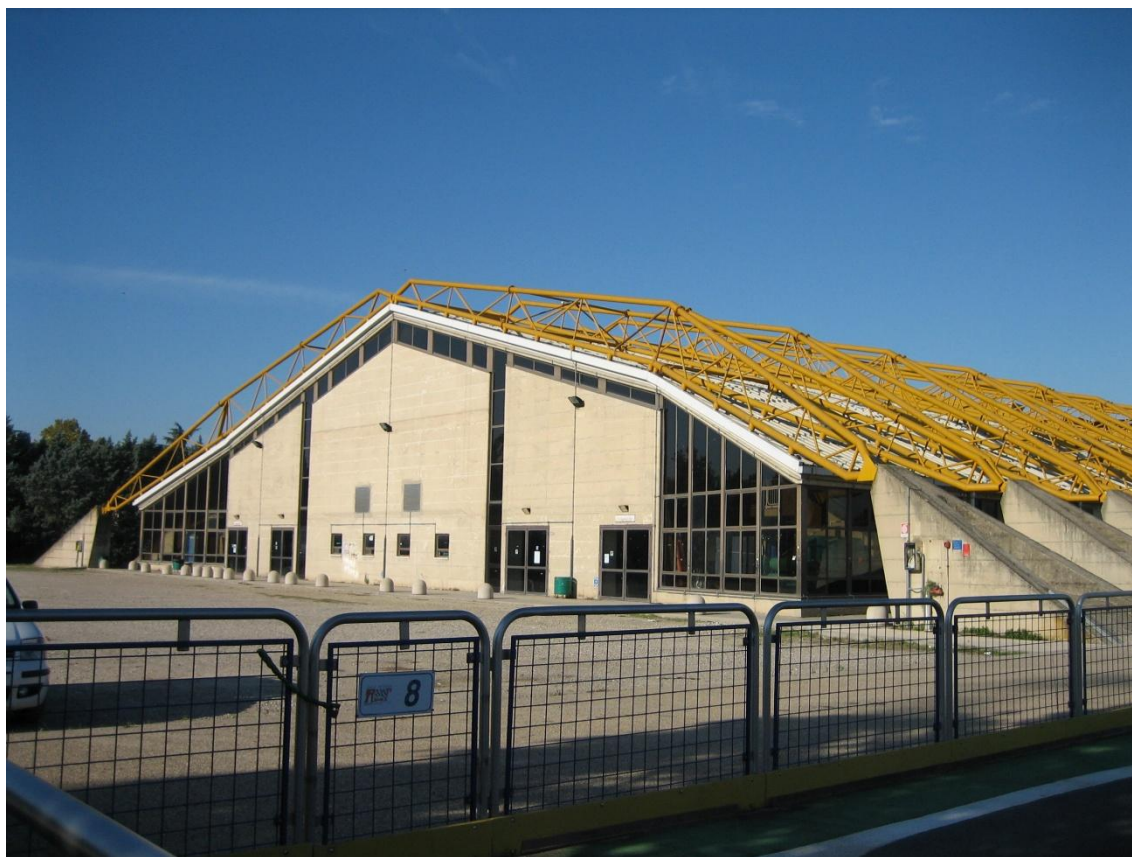
Vista della facciata Sud-Ovest
